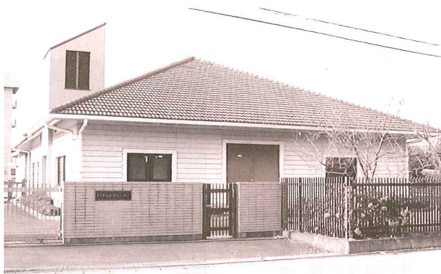
南赤田地区浄化センター
