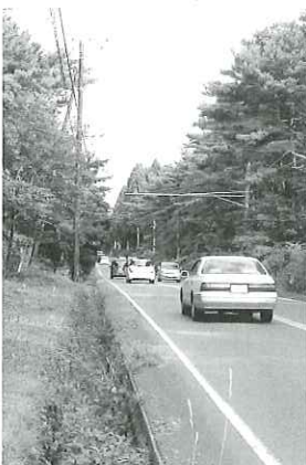
土側溝が続く国道400号
