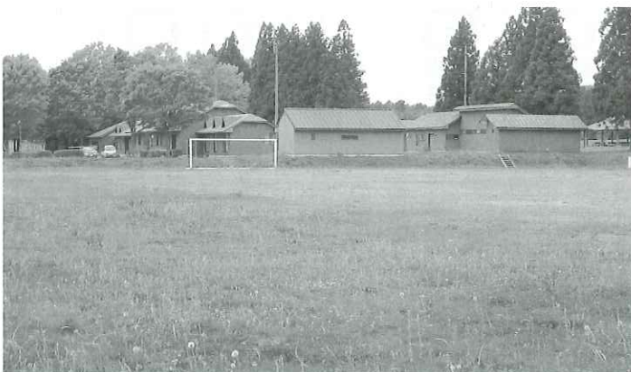
整備予定の青木サッカー場
