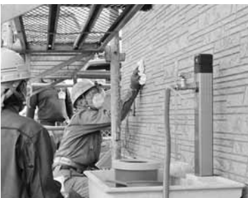
住宅除染の様子
