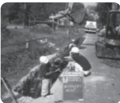
老朽管更新工事の様子
